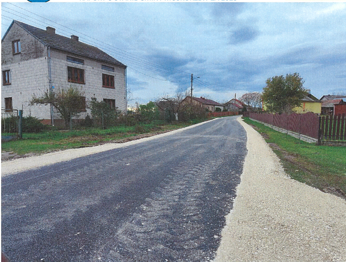
Zdjęcie 9. Remont drogi gminnej w miejscowości Mękarzów Nr 350004T odcinka w km 6+490 - 7+350
