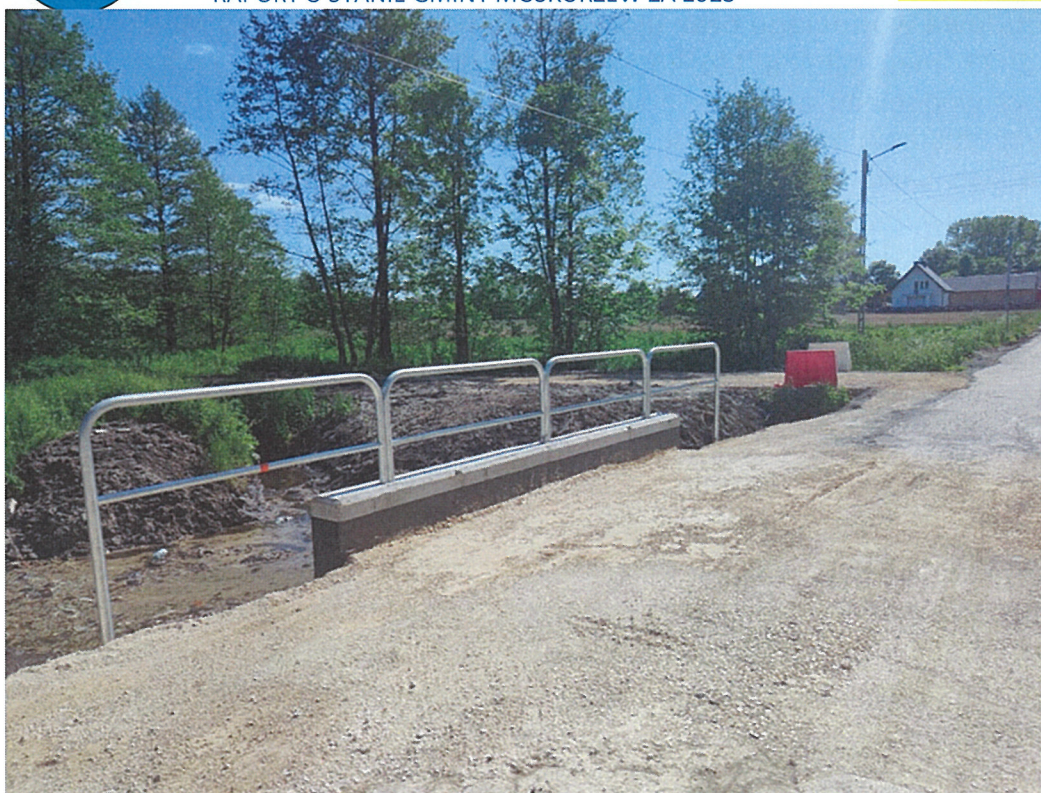
Zdjęcie 13. Modernizacja drogi gminnej w miejscowości Moskorzew Nr 350003T – w trakcie modernizacji przepustu
