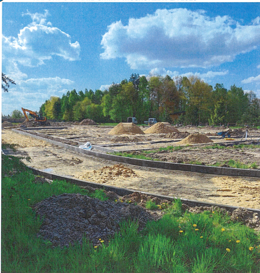
Zdjęcie 15. Rozwój infrastruktury sportowej w miejscowości Moskorzew – w trakcie robót budowlanych
