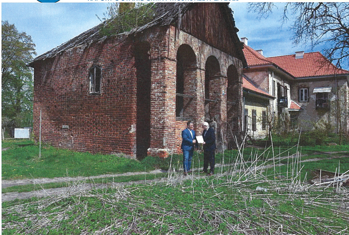
Zdjęcie 11. Wójt Gminy Moskorzew – Andrzej Walasek z wykonawcą robót budowlanych Panem Sławomirem Ostrowskim
