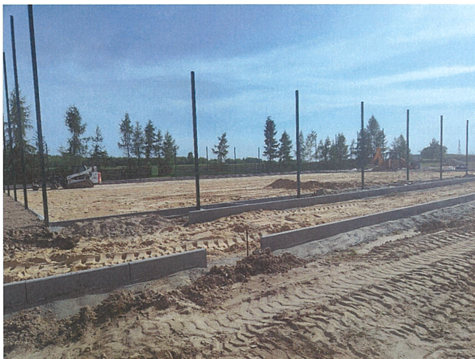
Zdjęcie 14. Rozwój infrastruktury sportowej w miejscowości Moskorzew – w trakcie robót budowlanych
