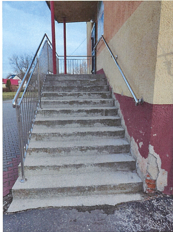
Zdjęcie 4. Schody przy budynku Urzędu Gminy w Moskorzewie przed modernizacją
