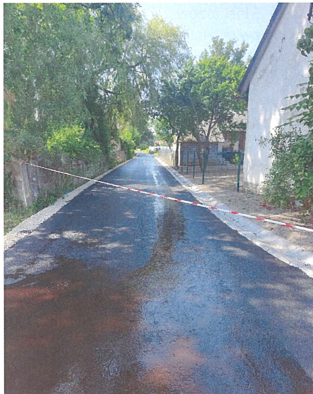
Zdjęcie 2. Przebudowa drogi wewnętrznej w miejscowości Moskorzew dz. nr 372 na odcinku o długości 1000 m – po zakończeniu robót budowlanych
