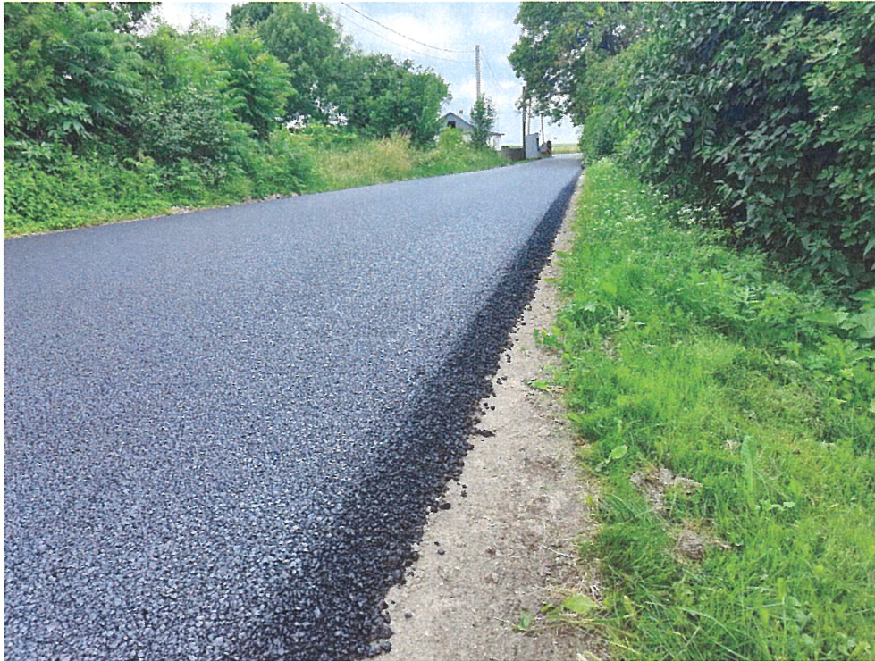
Zdjęcie 1 Modernizacja drogi gminnej w miejscowości Chebdzie nr 350011T na odcinku o długości 650 m – w trakcie robót budowlanych
