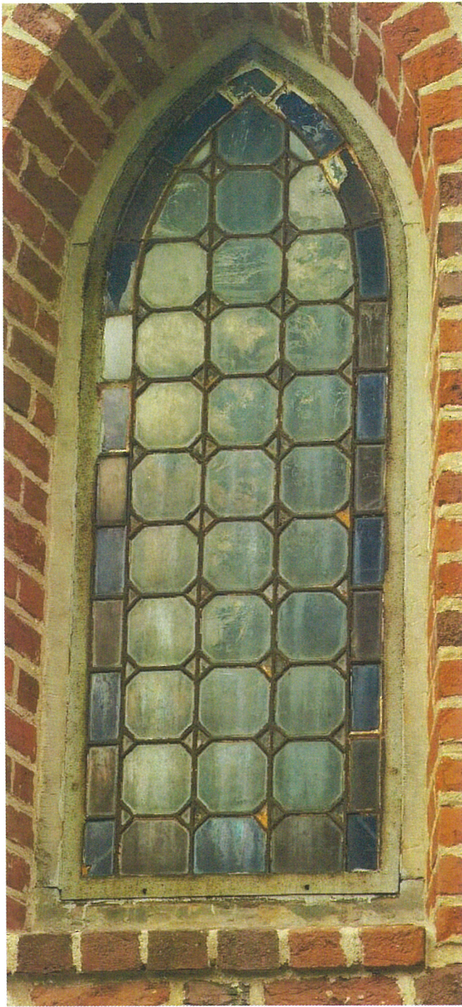
Fot. 3,4. Okno witrażowe w nawie kościoła. Widoczne bardzo mocne zabrudzenia, liczne uzupełnienia i kity, korozja siatki stalowej. Wyk. G. Kostecki 2023.
