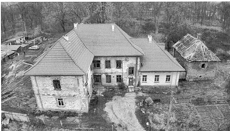
Zabytkowy budynek „Oficyny dworskiej” powstałej w XIX w. po realizacji robót budowlanych
